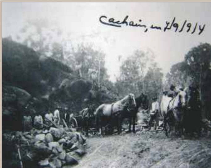
No início do século XX era comum a extração de blocos de diabásio para a pavimentação da cidade com paralelepípedos e lousinhas. As lavras eram pequenas e a técnica de beneficiamento totalmente manual. Acima imagem deste tipo de mineração no bairro Cachoeira, ao norte da cidade, em 1914. Acervo Casa da Memória de Curitiba.
